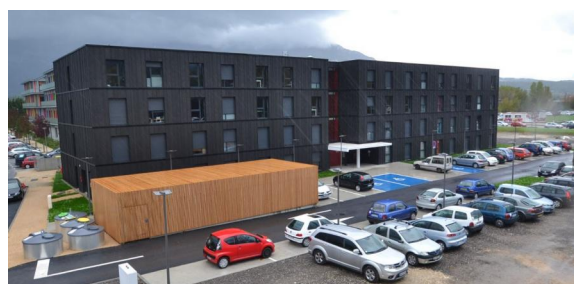
Construction modulaire 120 logements étudiants
