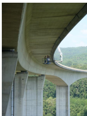
AUSCULTATION RADAR DU TABLIER DU VIADUC DE PONCIN SUR L'A40
