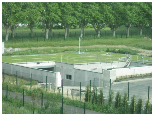
STATION DE TRAITEMENT DES EAUX USÉES CLÉ EN MAIN RÉALISÉE POUR LA SOCIÉTÉ NATUREX ET ENTERRÉE À -7M
