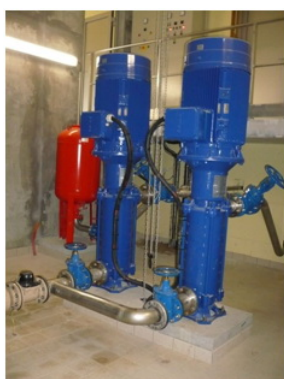
MAÎTRISE D'ŒUVRE - EXEMPLE DE SUIVI DE CHANTIER
