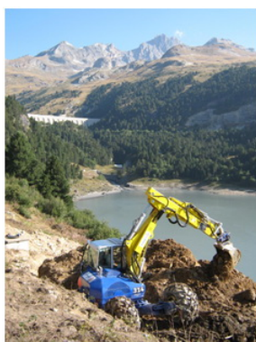
MAÎTRISE D'ŒUVRE - EXEMPLE DE SUIVI DE CHANTIER
