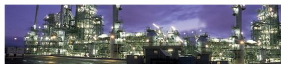
INSTALLATIONS GÉNÉRALES POUR L'INDUSTRIE PÉTROCHIMIQUE
