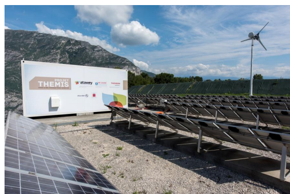
INSTALLATION PRÈS D'UN REFUGE (CONDITIONS EXTRÊMES)
