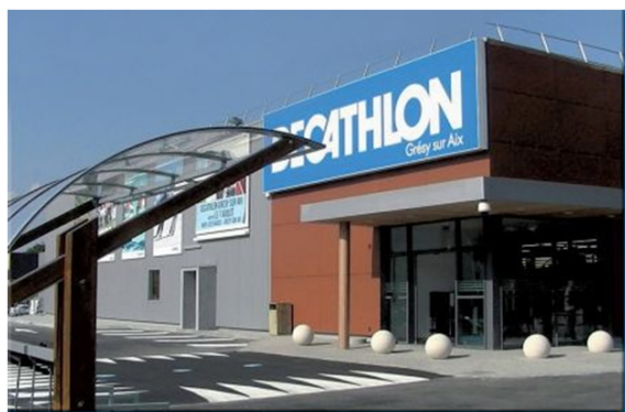
MAINTENANCE GÉNIE CLIMATIQUE, MAGASIN DÉCATHLON DE GRÉSY SUR AIX (73)
