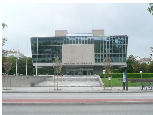
MAINTENANCE MULTI-TECHNIQUE, PALAIS DE JUSTICE D'ANNECY (74)
